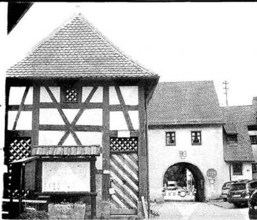
Bild 2 – Das Brunnenhaus des Tiefen Brunnens (links) neben dem Bayreuther Tor in Betzenstein.
